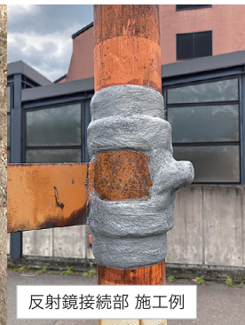
ウルトラワックステープ添接部施工事例
