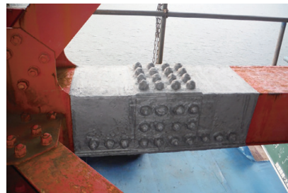
ウルトラワックステープ添接部施工事例
