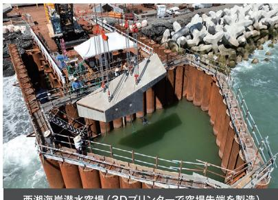
西湘海岸潜水突堤（3Dプリンターで突堤先端を製造）
