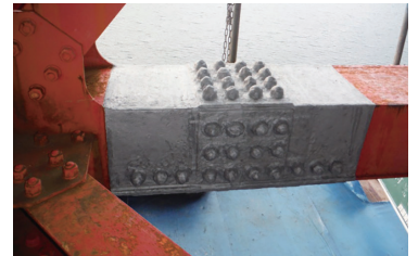
ウルトラワックステープ添接部 施工事例
